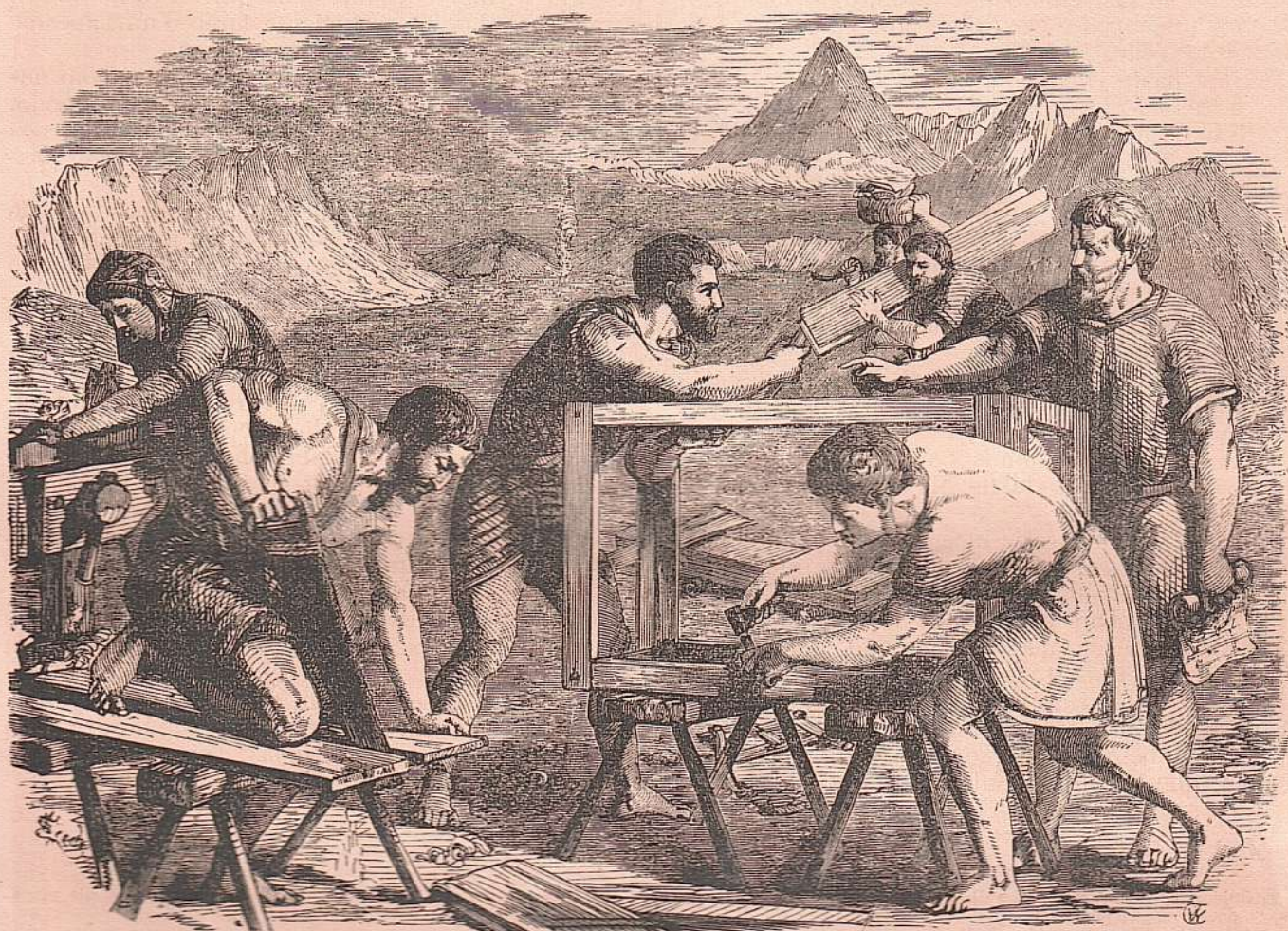
Construção da arca
